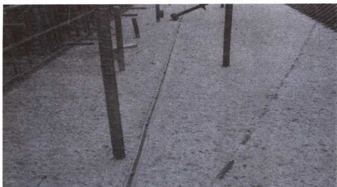
SJ 止水条安装
