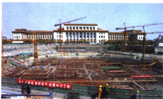
国家大剧院施工现场
