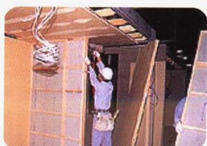
⑧ 安装隔墙和配件
