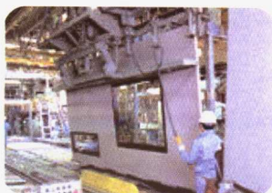
⑦ 安装外墙板
