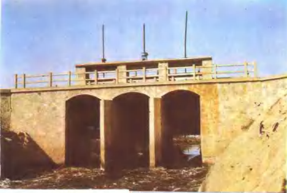
◀ 东明渠汪家庄水闸
