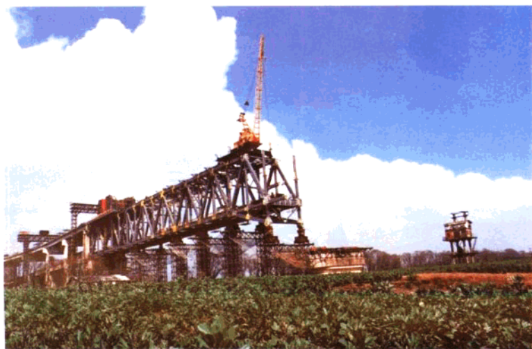
第1孔钢梁架设接近1号墩
