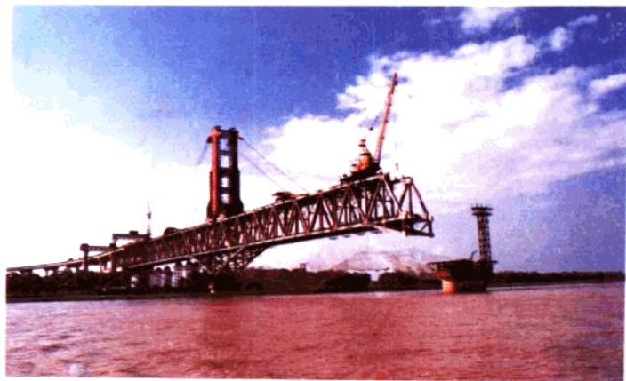
采用单层吊索塔架架设钢梁接近 2 号墩
