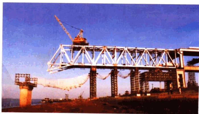
南岸在膺上架设第 11 孔钢梁
