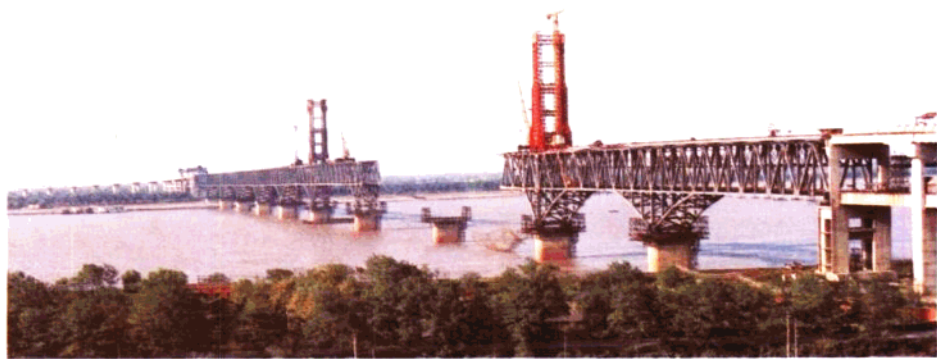
南岸拼双层吊索塔架,同时架设第9孔 180m 跨钢架
