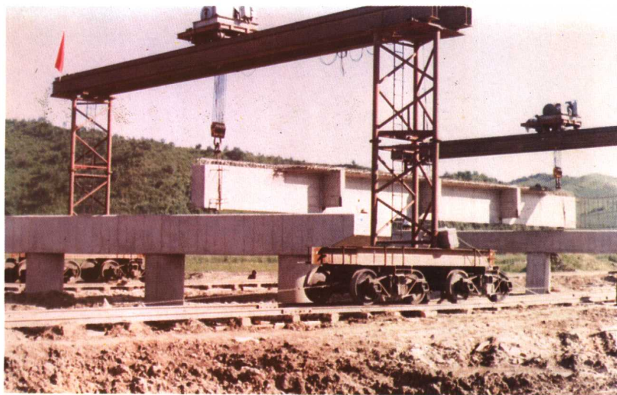
⑳跨墩龙门架安装“T”型梁
