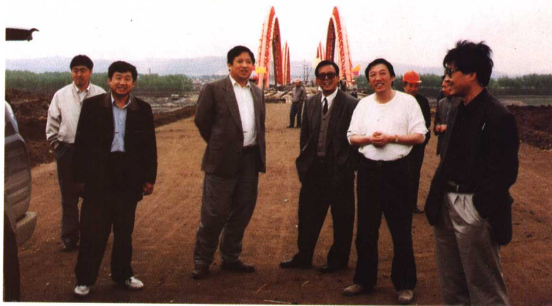
②⑨ 省交通厅、哈同公路公司领导在工地现场
