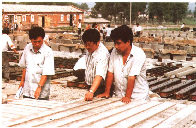
③②哈同公路公司领导在小预制构件施工现场指导工作
