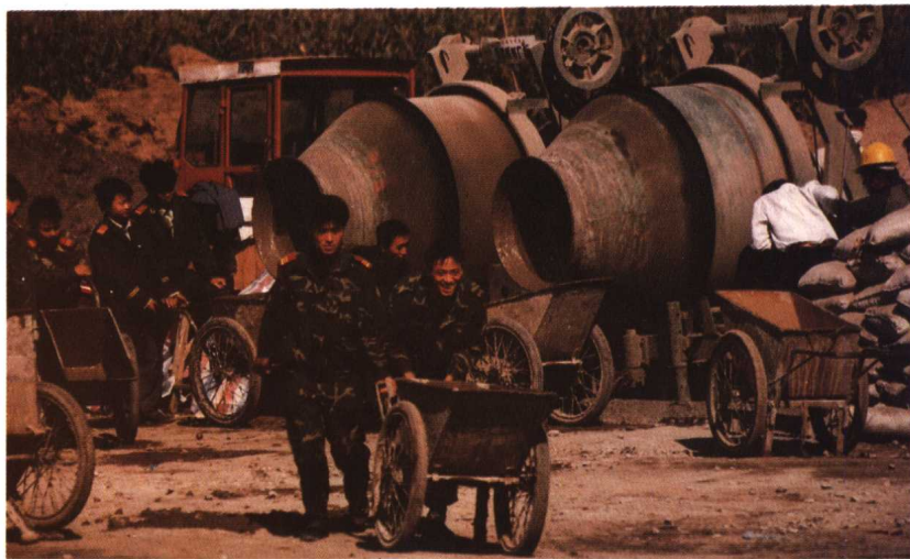
⑲武警官兵奋战在施工现场
