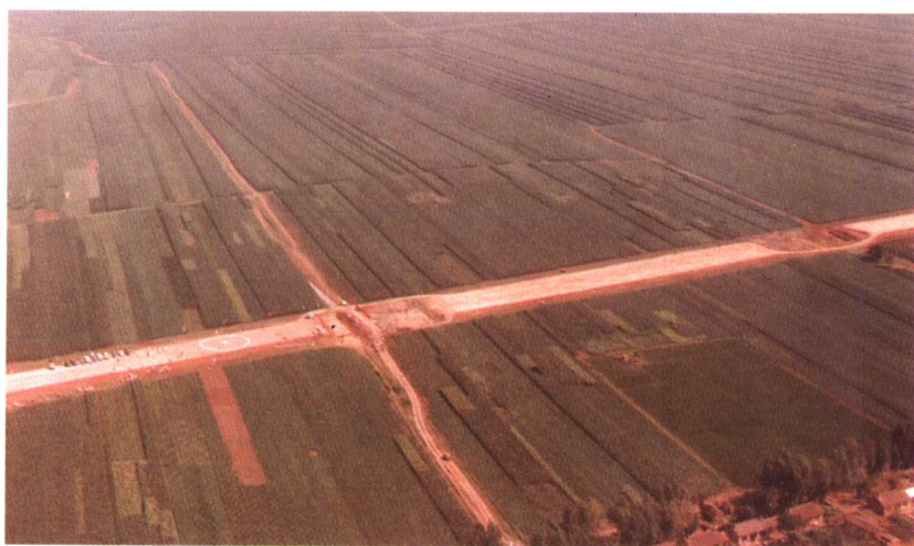
①⑦俯瞰建设中的哈同公路
