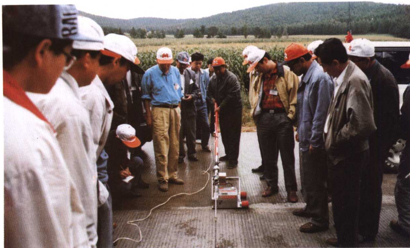
②⑤从美国引进的混凝土软切缝机在施工中得到推广应用
