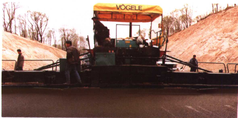
③③从德国引进的福格勒沥青混凝土摊铺机在施工中
