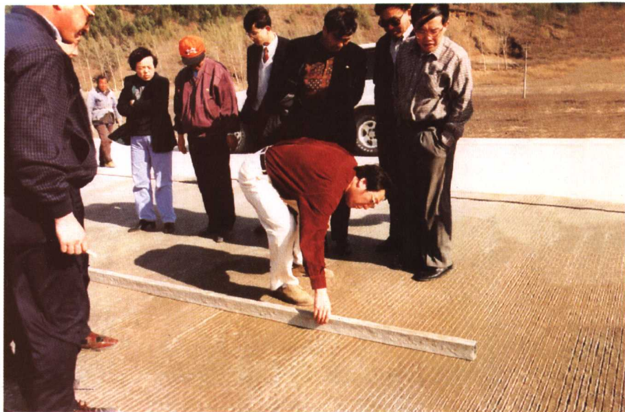
③①哈同公路公司总经理陈文智在施工现场
