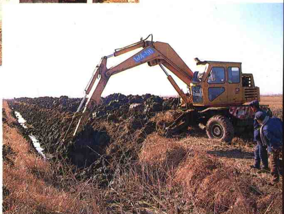
排水渠机械化清淤
