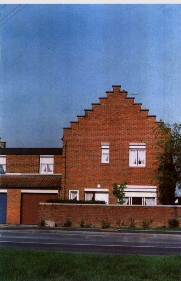
采用新型墙体材料,施工安装快捷。
