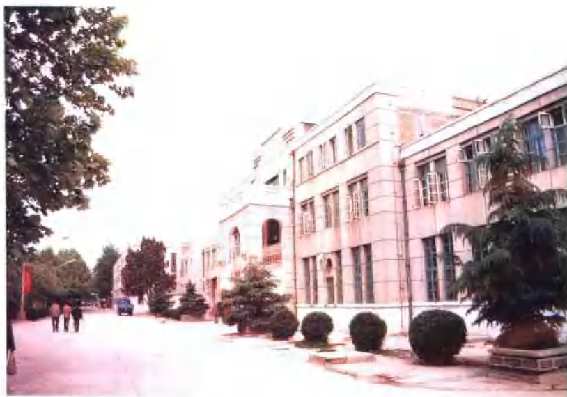
▲厂生产车间主场房一瞥
