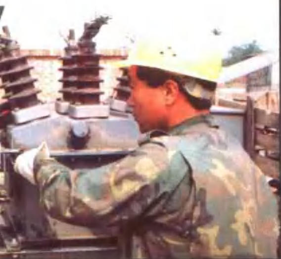
修高压故障自动切除装置。
