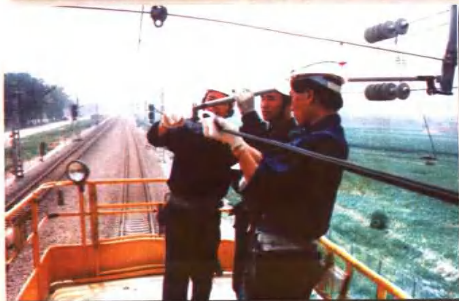
◀ 保定供电段运用接触网综合作业车检修设备。
