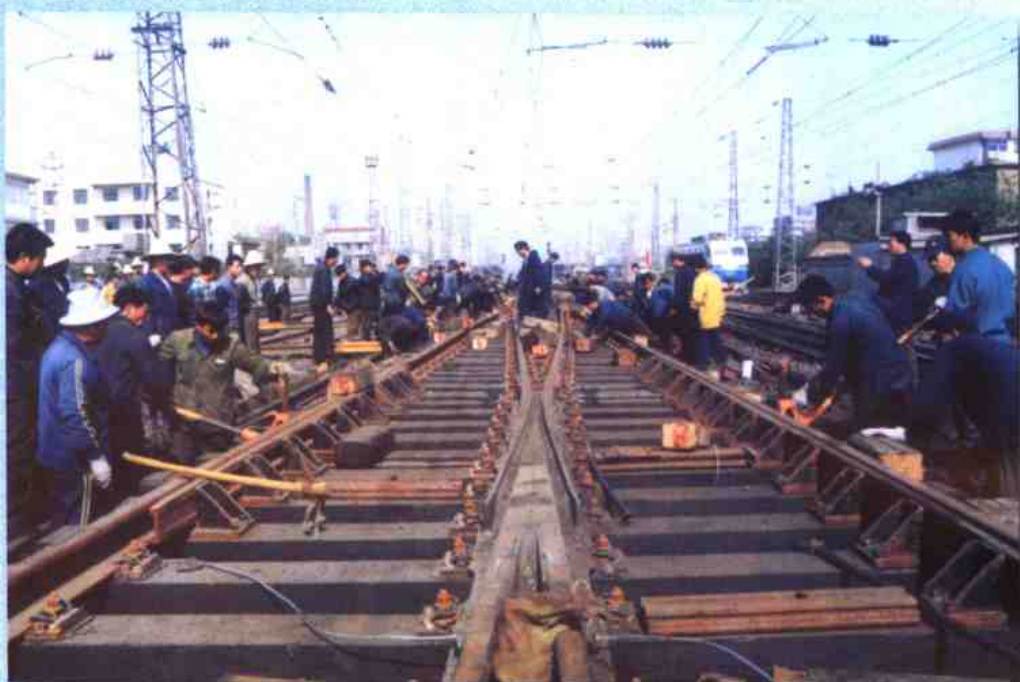
京广线整体更换道岔大施工。
