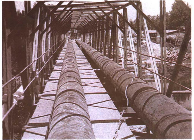
北京市东南郊高压煤气管道改造工程——跨河管架桥,由北京市市政工程局承建,北京市第四市政工程公司施工。
