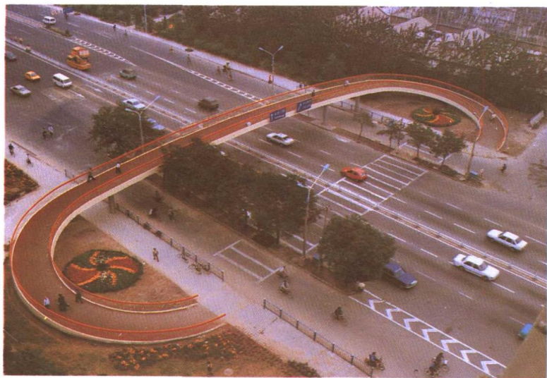
北京市月坛南侧人行天桥,由北京市市政专业设计院设计,北京市市政工程局承建,北京市第二市政工程公司施工。
