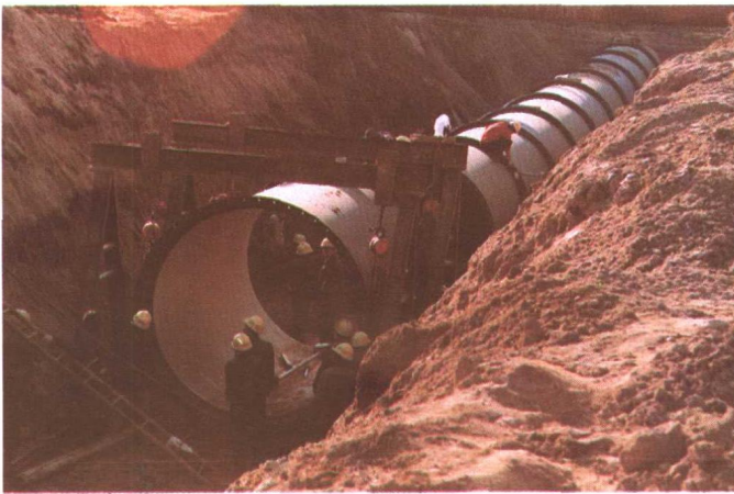
▲ 沟槽内龙门架安装情况
