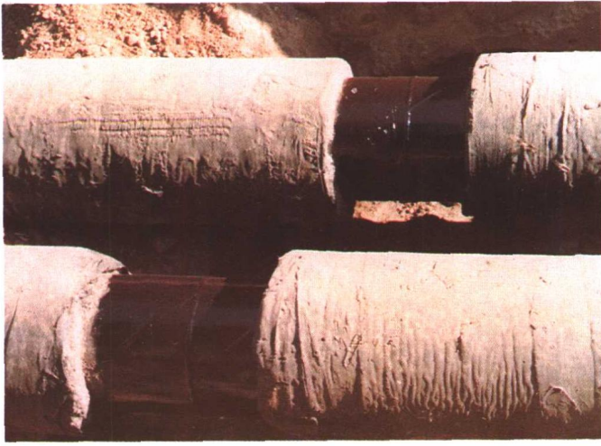
广播局热力珍珠岩保温管道直埋工程。由北京市市政工程局承建,北京市第四市政工程公司施工。
