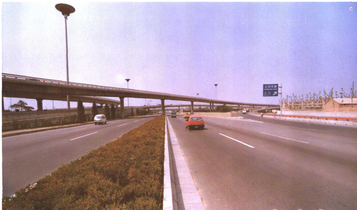
北京市机场路四元桥工程由北京市市政工程局承建， 北京市第一市政工程公司施工
