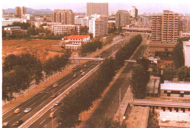
▲ 北京市西三环道路改建工程
