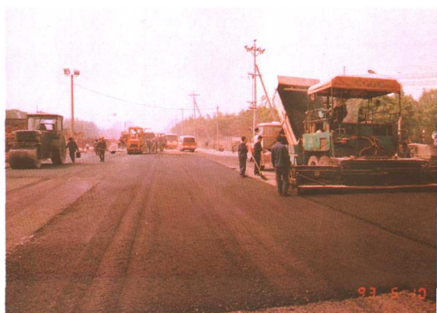
▲ 四元桥道路工程沥青碎石联结层施工
