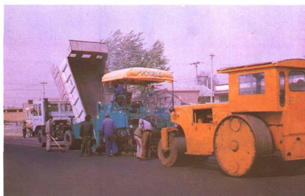
▲ 四元桥道路面层配套机械化施工
