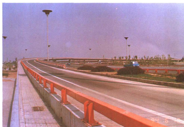
▲ 四元桥桥头引道
