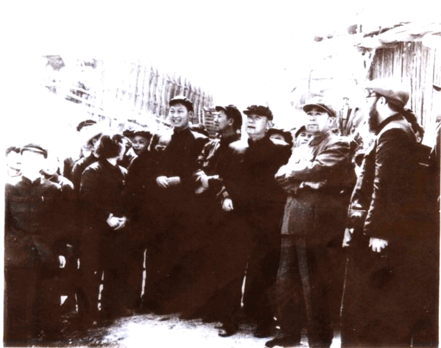
1958年4月周恩来总理在三门峡水利枢纽工地视察
