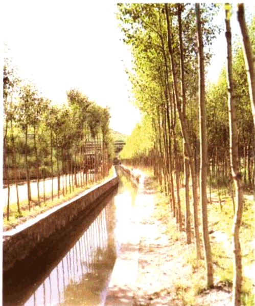
青海省湟源县湟海渠沿渠风光
