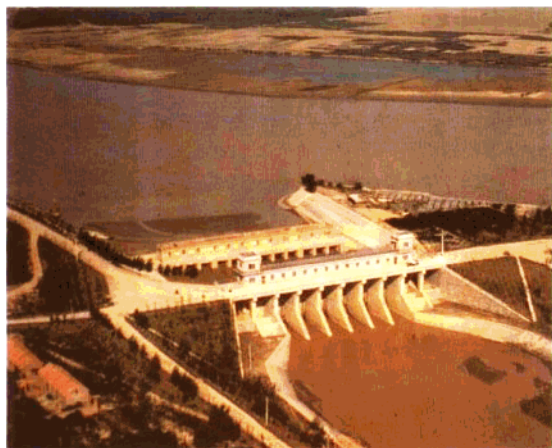
山东省打渔张引黄灌区引水闸
