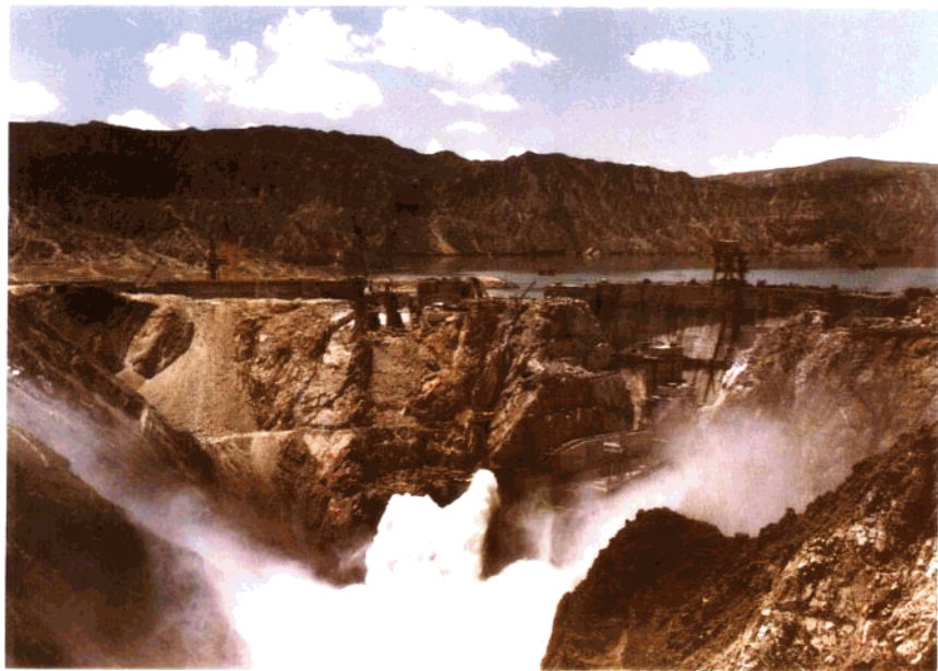
龙羊峡水电站大坝泄水宏伟景象
