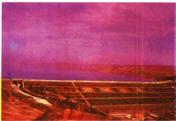
采用水中倒土筑坝技术的汾河水库大坝
