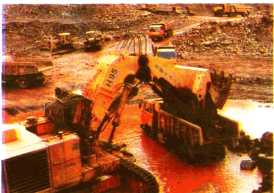
小浪底水利枢纽泄洪工程消 力塘开挖施工景象 刘凤翔摄
