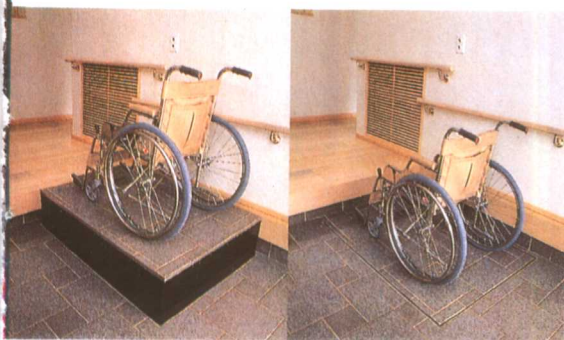
12.门厅上踏步装置。有一部分地面可升降，平时和门厅地面一样高，轮椅可自由出入。
