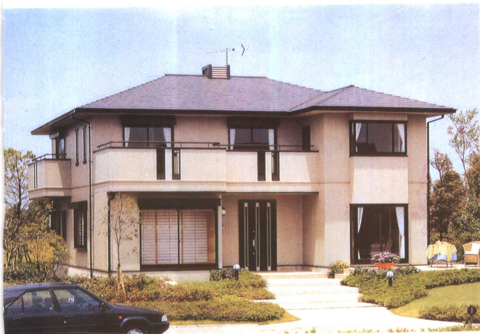
1.外观。采用简洁精美的现代设计。外墙用喷涂层，屋面用日本瓦。
