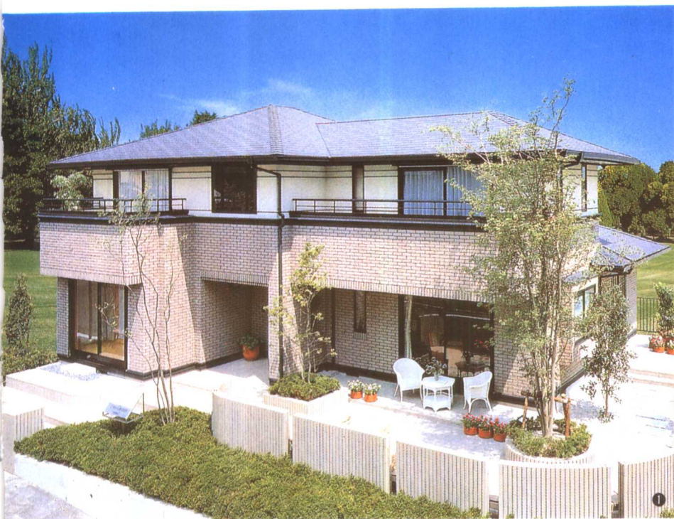
1.外观。四坡屋顶，舒展大方。外墙用粉刷和砖墙对比，给人以宁静高雅之感。
