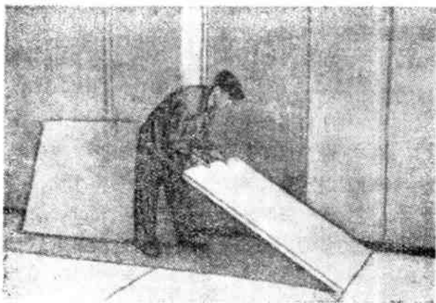
圖 5 鋪設柯爾金隔音板
