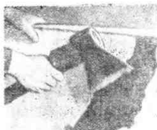
圖 6 砍掉柯尔金隔音板的凹部
