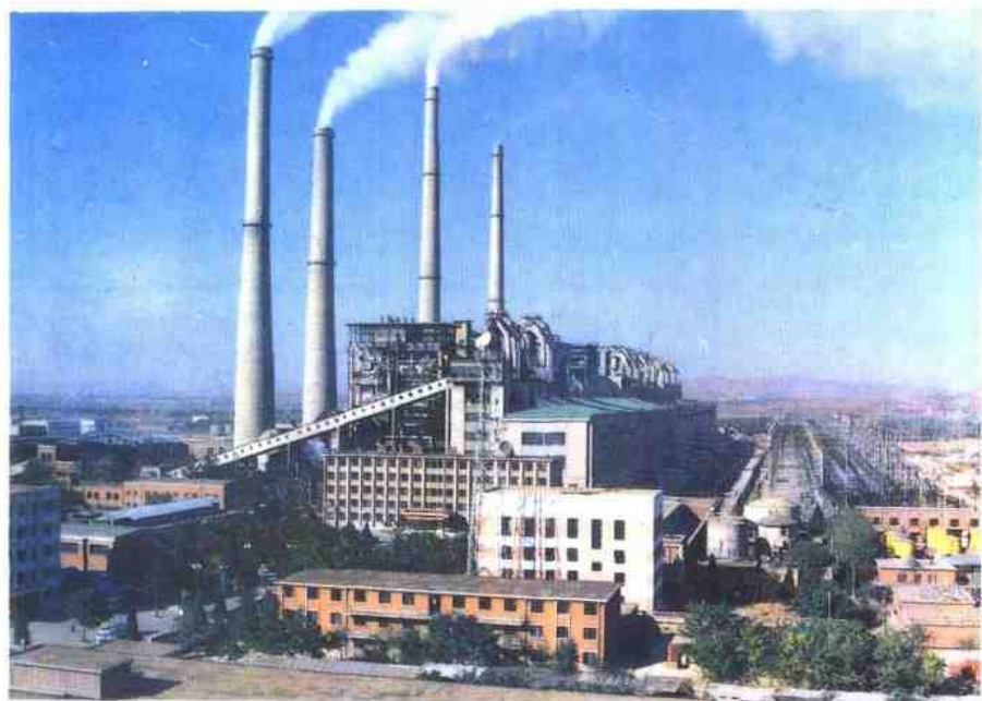
唐山陡河电厂全景
