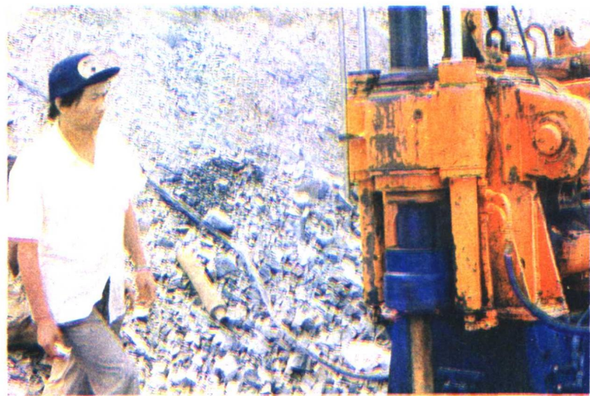
彩照 8 香港小柴湾辟山填海工程试验现场
