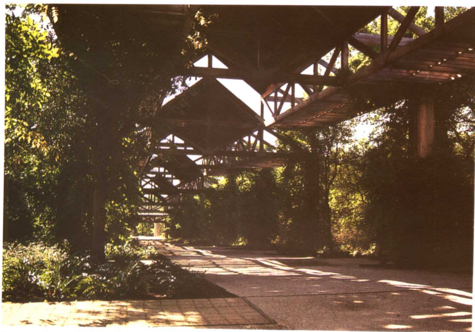
▲ 缠绕着柴藤的绿廊将入口建筑和园区中心联系在一起。
