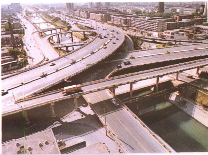
图3 天宁寺立交桥
