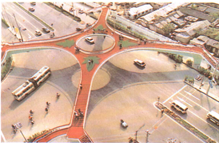
图 6 蒋宅口人行过街桥
