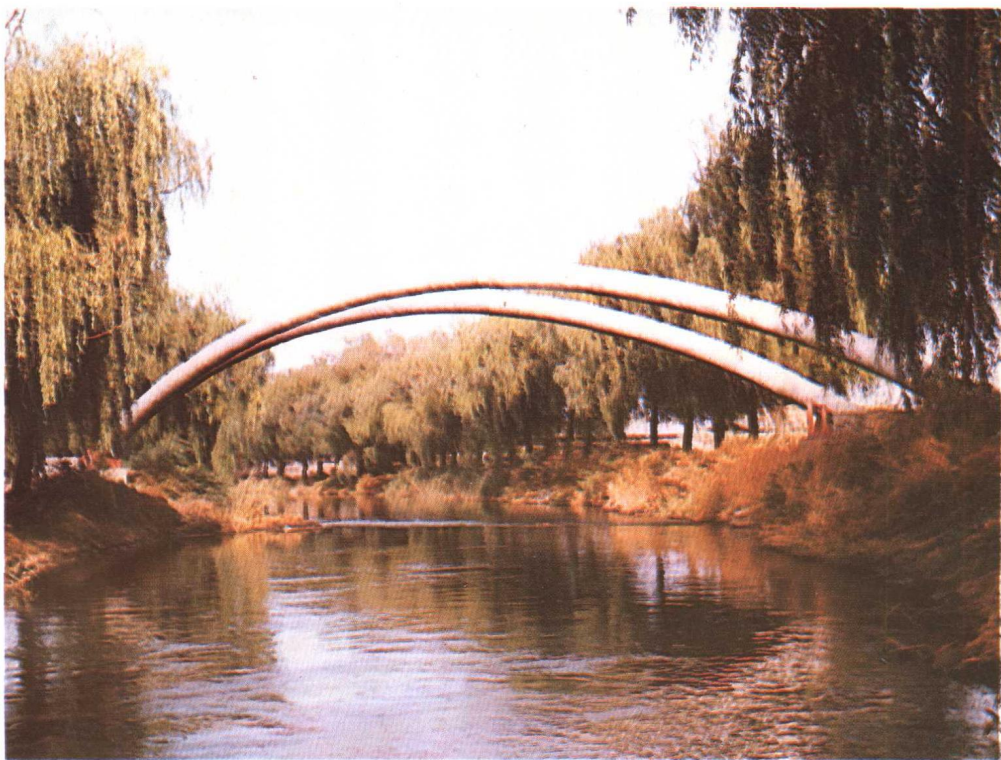
图 8 东南郊高压煤气管道跨河
