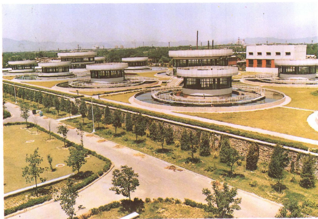
图10 水源九厂加速澄清池
