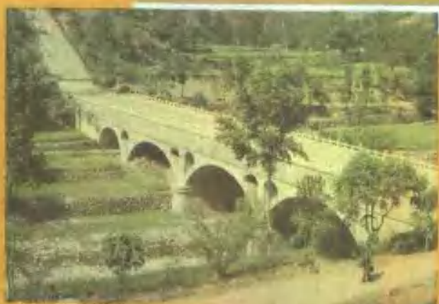
建都口倒虹吸公路桥
