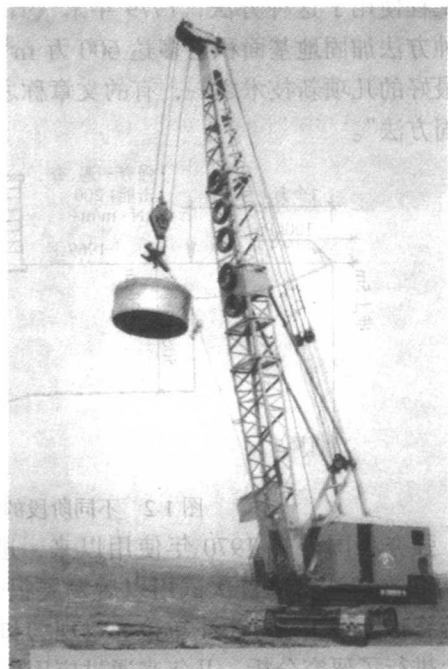
图 1-1 加固地基强夯法起吊夯锤图
