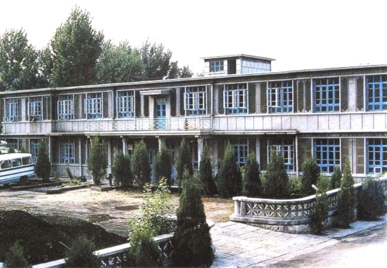
16. 交通局办公楼
