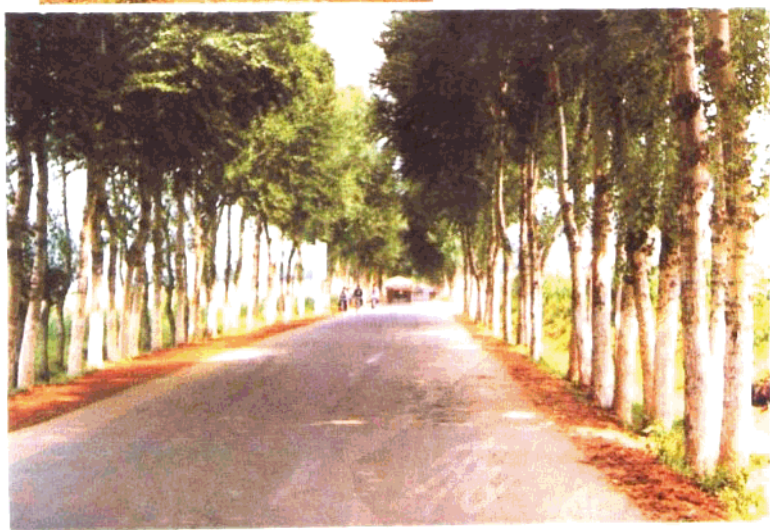
12. 第一段沥青（渣油）路面
