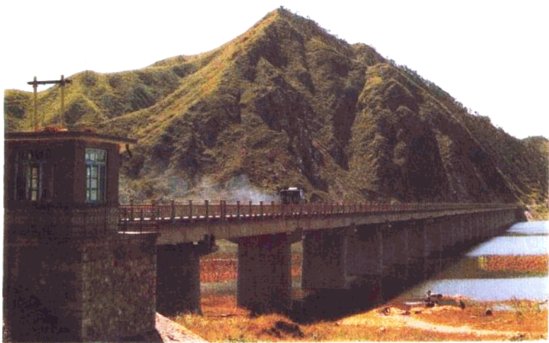
3. 邦宽线洒河桥灤河大桥
