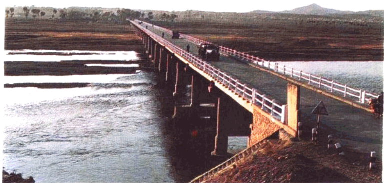
1. 三抚线郭沟滦河大桥
