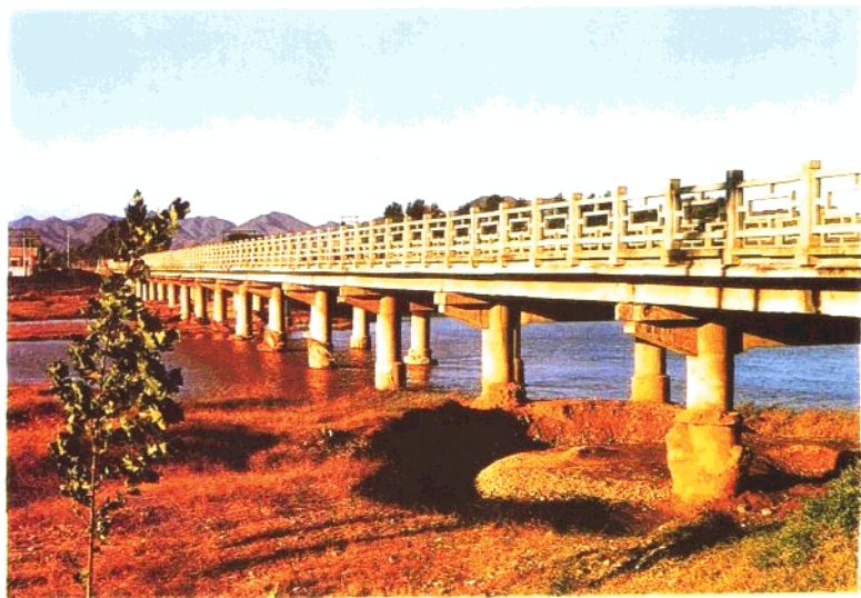
5. 迁西县自行设计施工的第一座大桥——丰董线沙河大桥
