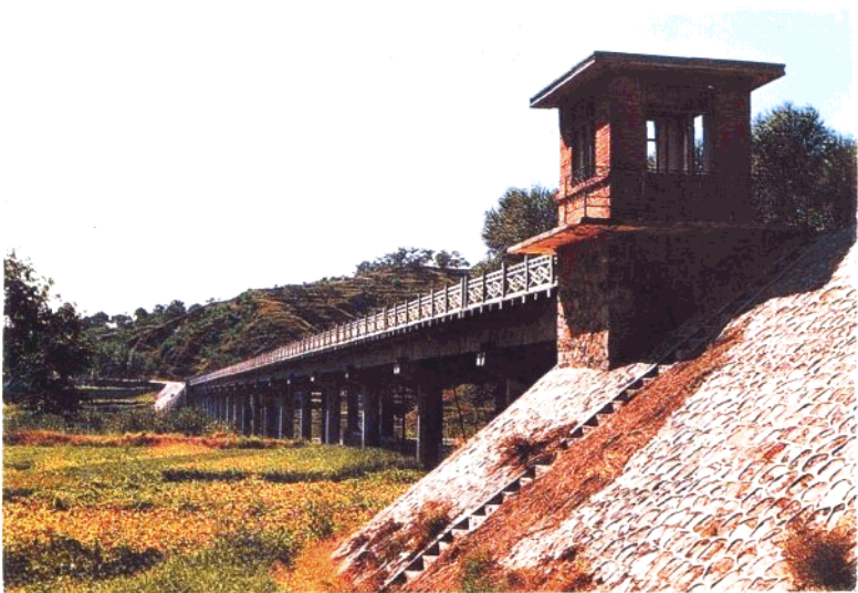
4. 北建线汉儿庄洒河大桥
