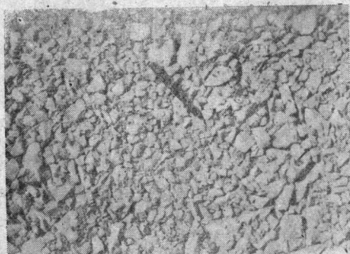
图2 #83在压实的石碴層上用1.5—2.5公分碎石填縫后的外觀
