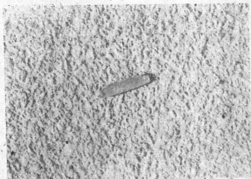
图10 #151第二遍嵌縫料(用小石与石膏混合)压实穩的外觀
