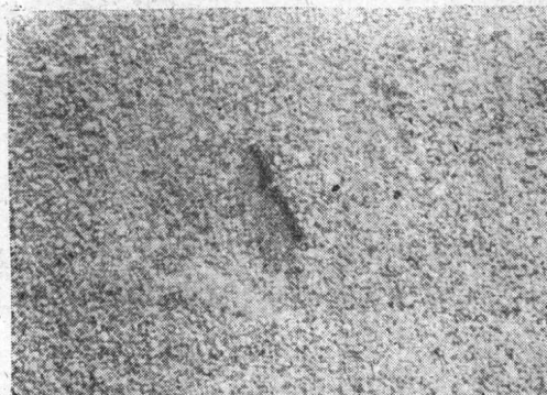
图11 #126第二遍嵌縫料(用0.2~0.7厘米小砾石)压穩后的外觀
