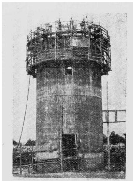
图 6 1955 年修建吉林某厂 400 吨钢筋混凝土水塔时 使用滑动模板施工情况
