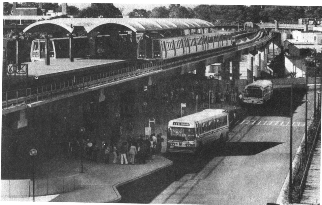
华盛顿特区的罗德岛大道车站（Rhode Island Avenue Station）就是一处新建的地铁系统，它的建设成为全美运输系统建设复兴的标志。
