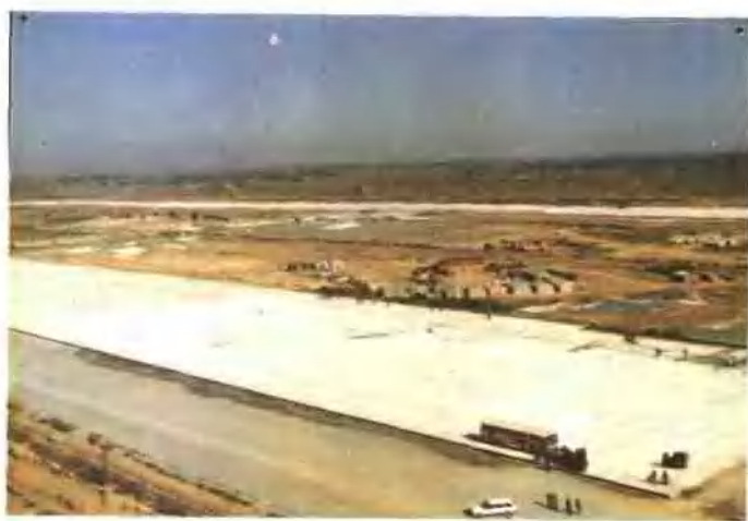
在建中的石家庄机场. 上图为机场跑道. 下图为停机坪
