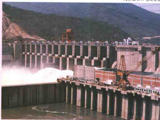
闽清县水口电站全景
