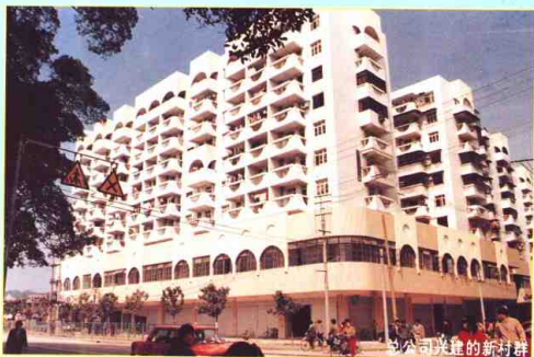
总公司兴建的新村群
