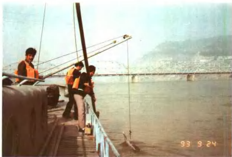
□兰州水文站职工船上 测流、取含沙量水样 (王清叶提供)
