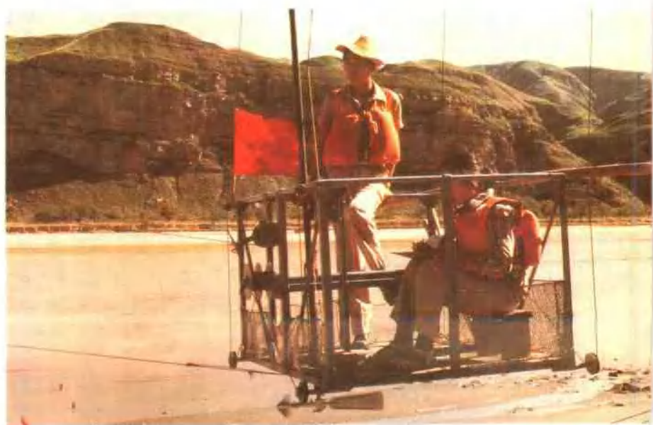
□吴堡水文站职工在缆车上测流 (黄河博物馆提供)
