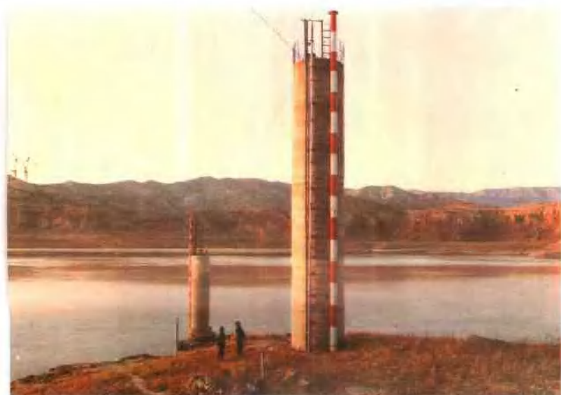
□史家滩水位站声波自记水位计 (黄河博物馆提供)
