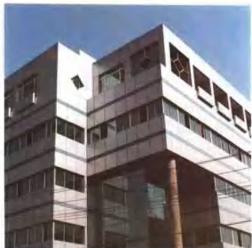
门廊入口外景
