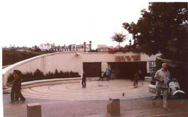
图1.3 法国巴黎地铁车站入口。周边地形与车站室内外空间自然过渡
