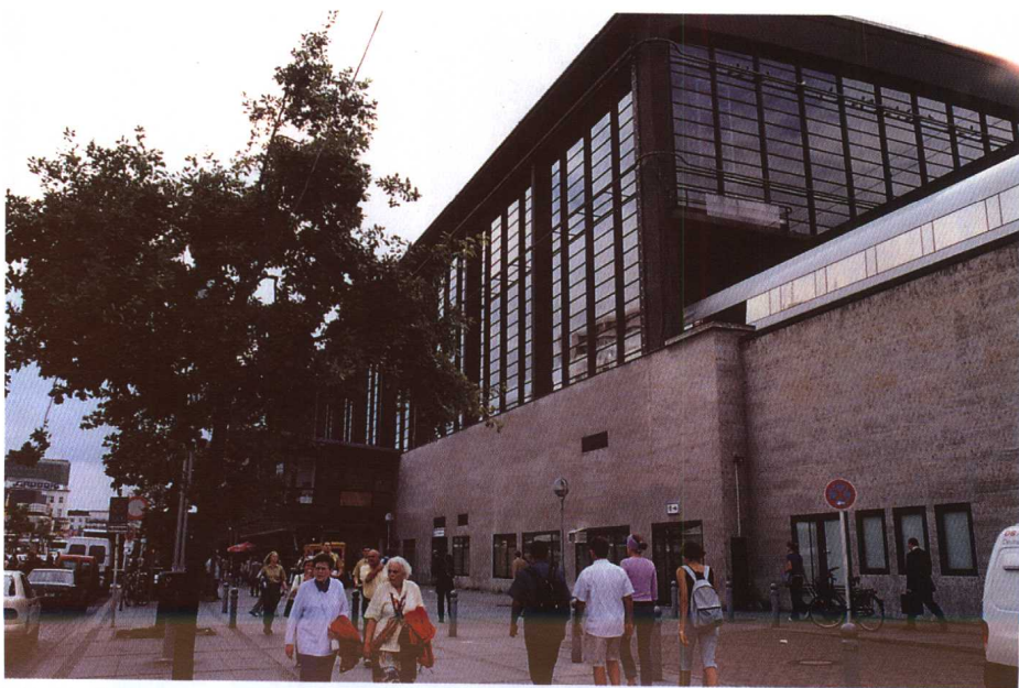
图 1.12 德国轻轨车站外部环境。建筑、人行道与绿化合理布置
