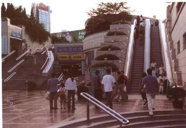
图1.2 上海静安寺地铁站下沉式广场。自动电梯、楼梯与花台有机组合
