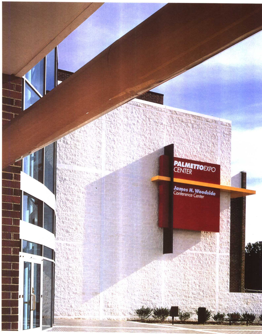
颜色鲜艳的室外标识牌为这座现代化建筑增添了光彩。该建筑物外表简洁, 主要使用了白色的灰泥粉饰外墙。紫色和黄色的木板镶嵌在墙内, 象征着这一地区纺织工业的悠久历史, 也代表着该中心的主要客户。
