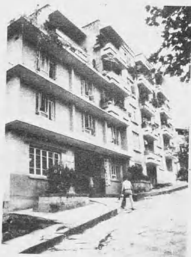
通江县妇幼保健站
