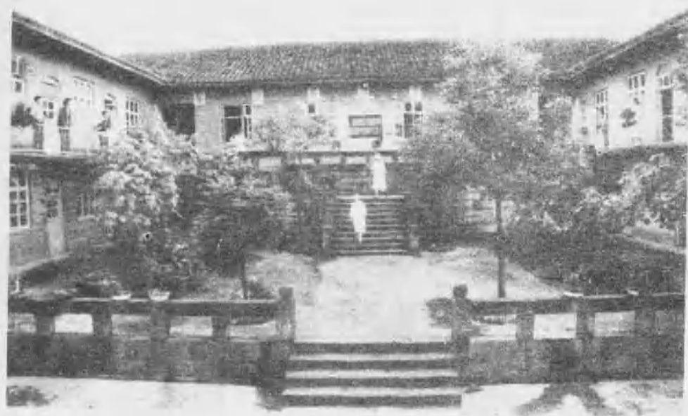
通江县民胜区卫生院住院部
