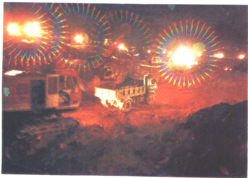
建设中的厦门经济特区湖里加工区
