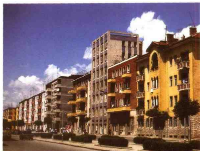
这是首都地拉那的大街。即使是现代建筑也有阳台。
