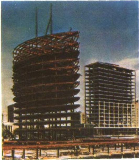
圖 A-9 鋼鐵建造者建築這些建築物，其中二個較高的，包括那棟不平常的橢圓形辦公大樓，都以鋼鐵為構架。
