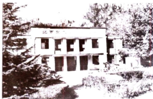
中国航天第 701 研究所办公楼
