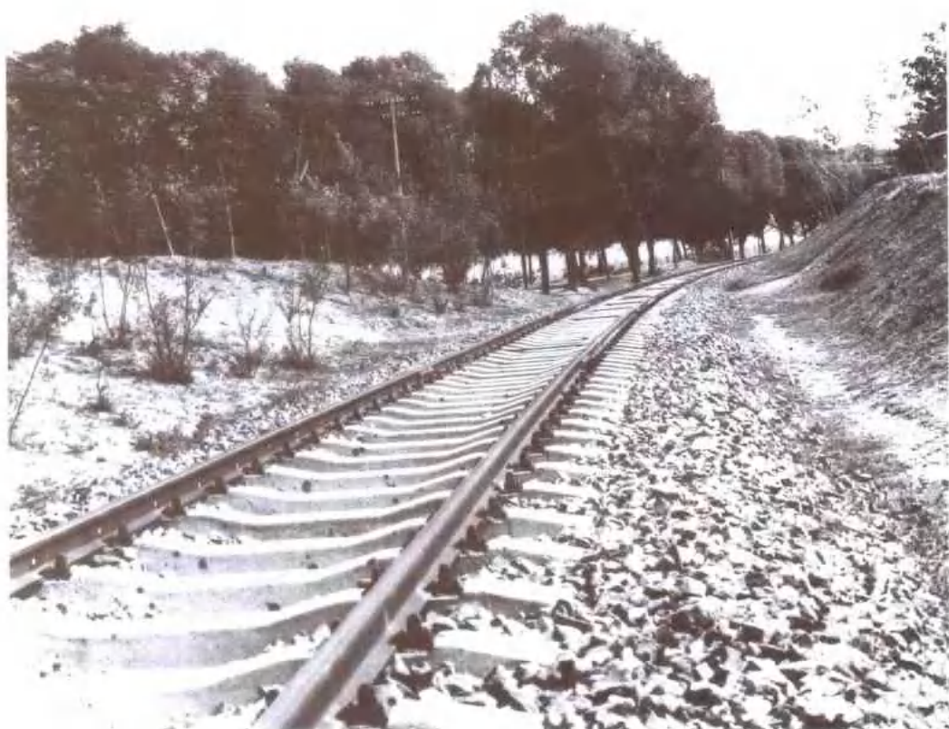
兰（考）—坝（东坝头）铁路
