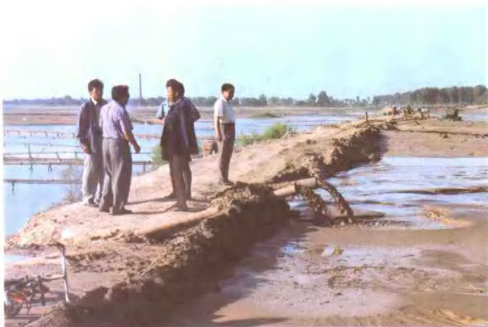
南北庄淤临施工现场
