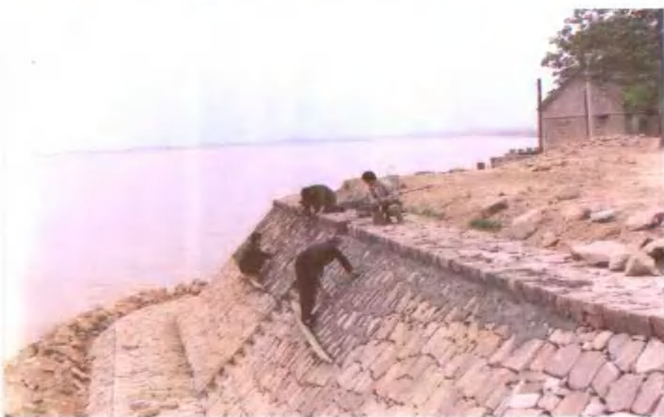
东险工28坝改建施工
