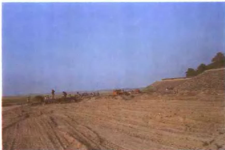
四明堂截渗施工现场
