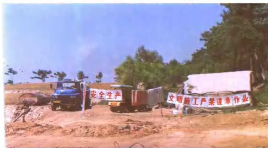
南北庄压渗工程施工现场
