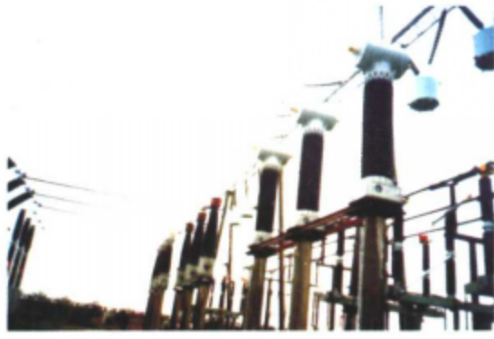
220kV SF 6 充气式及油浸式电流互感器
