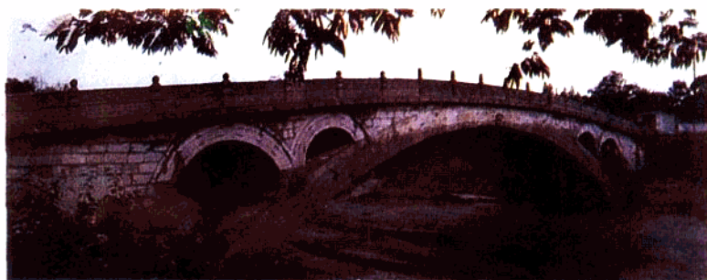
▲ 隋朝工匠李春建造的赵州桥，应用浅拱结构，长50.82米，跨径达37.4米，宽10米，至今完好。
