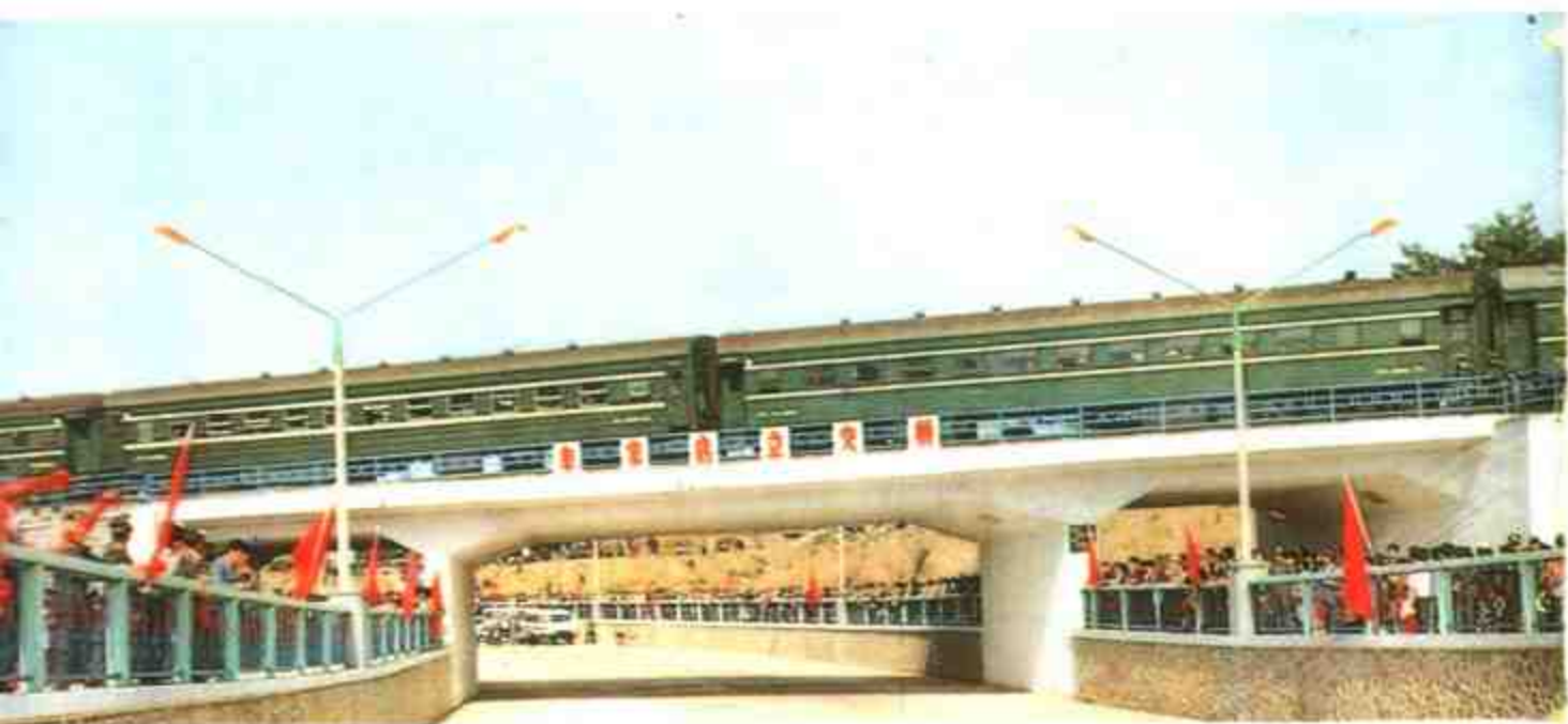
▲日均五千八百辆车次的京山线 卑家店道口，于1989年9月25日提前三个月建成铁路立交桥。
