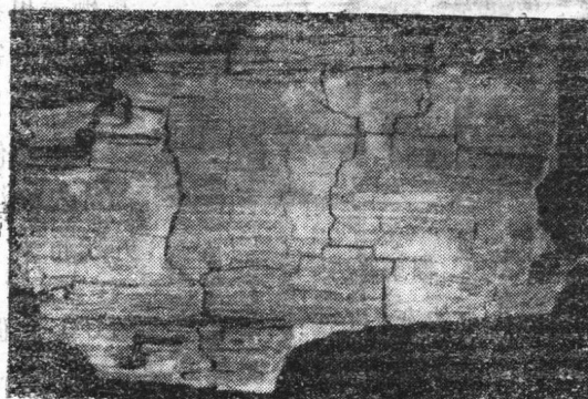
图8 木材褐腐后呈龟裂状
