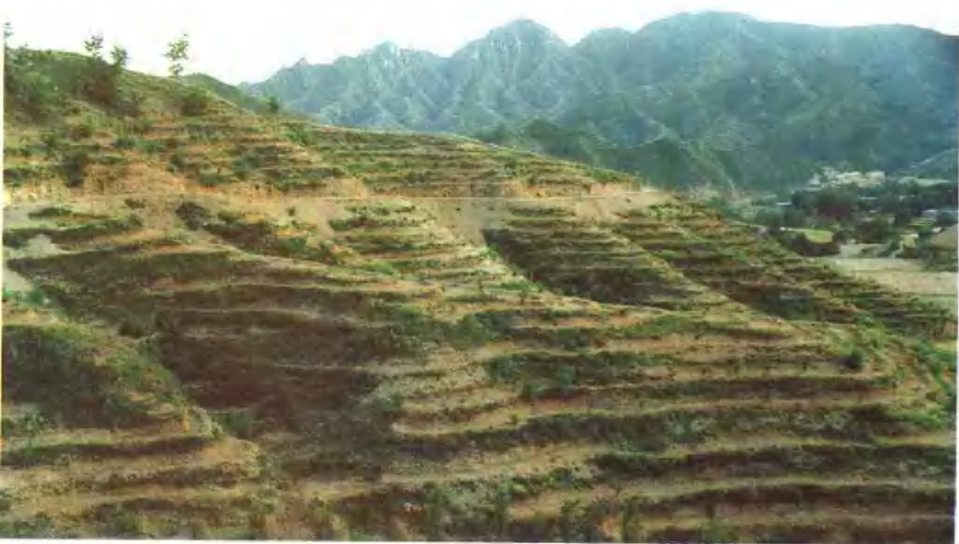
▲赞皇县许亭水土保持工程——水平沟
