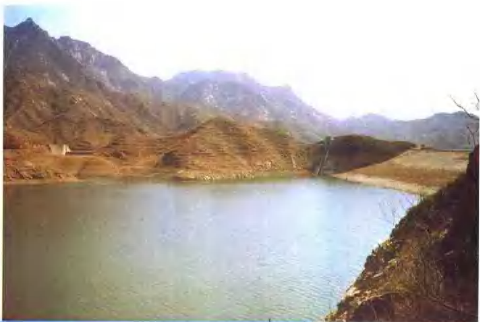
► 中型防洪灌溉工程——平山县石板水库
