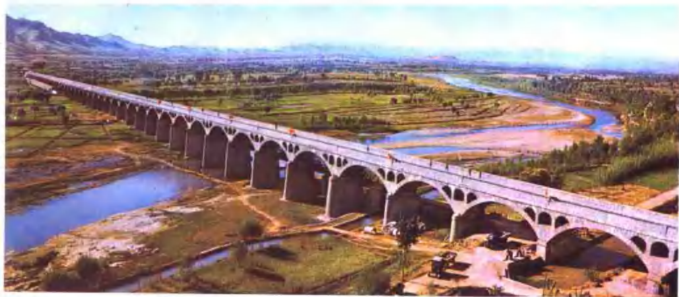
▲引岗灌区枢纽工程——群英大渡槽
