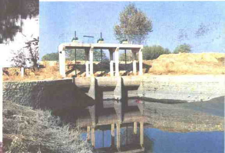
陡河灌区渠首闸
