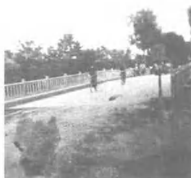
老陡河稻地公路桥
