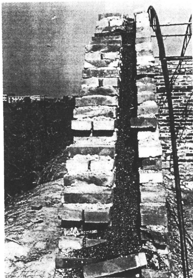
图 1-3 砖墙及有填充物的夹心墙
