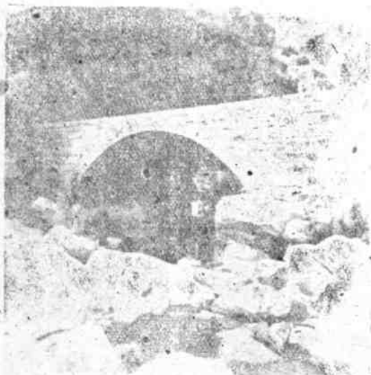
图2 天佛崖1/4拱度、拱跨10米的中型桥
