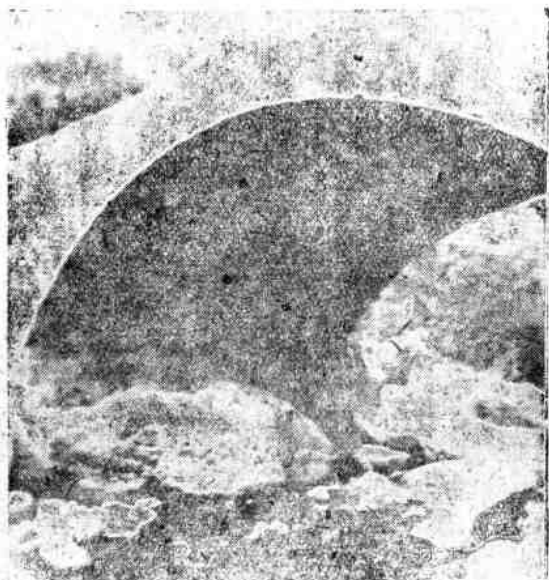
图7 天棚崖桥拱腹均部
