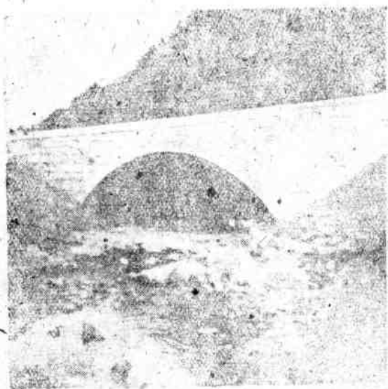
图3 鹤窝子1/4拱度、拱跨10米的中壅桥
