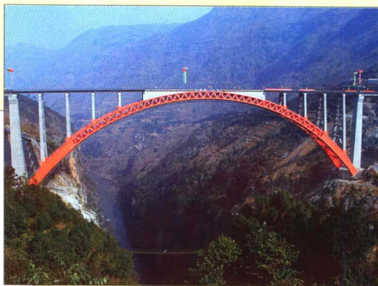
水柏铁路北盘江大桥主跨 236 米，是目前世界上最大跨度的单线铁路拱桥 周德民 摄
