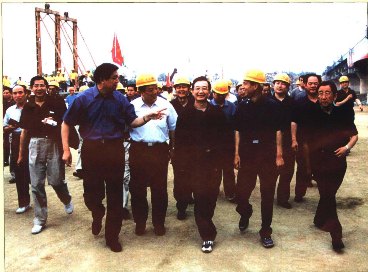
2002年6月22日，国务院副总理温家宝视察陇海线灞河大桥抢险改线工地
