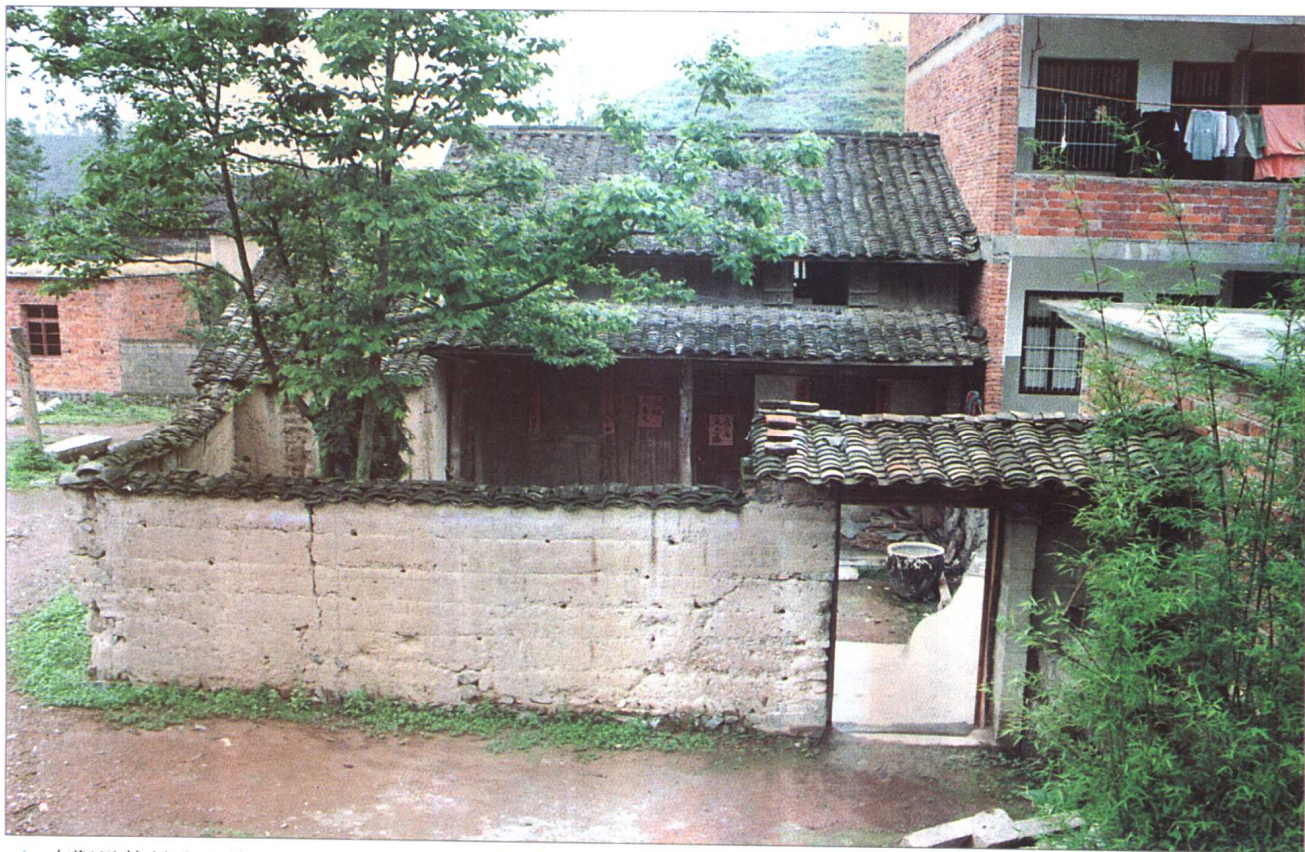
▲ 东阳里坞村生土墙民居
