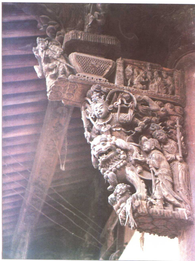
▲ 东阳清代住宅月梁端部阴刻龙须
