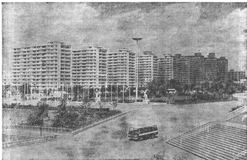
图 0-4 上海漕溪北路高层住宅
