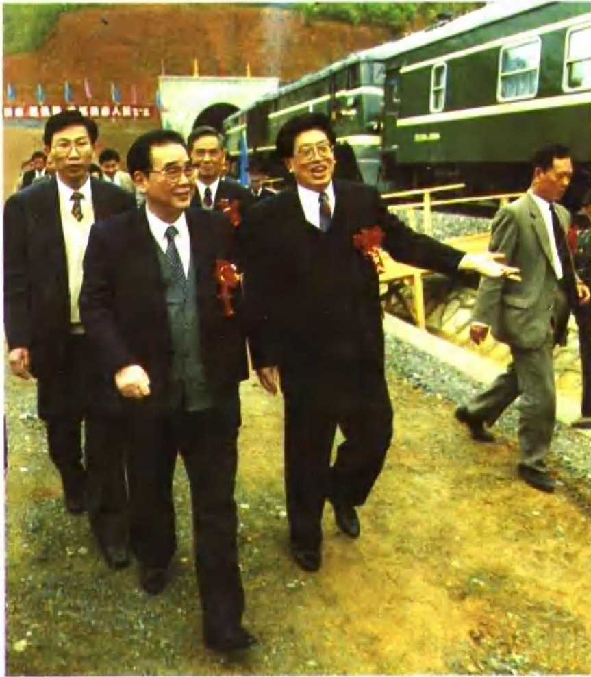
1997年3月18日,李鹏总理参加南昆铁路全线铺通 庆祝大会后视察永乐一号隧道。
