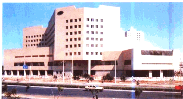
8 六建承建的 国际会议中心
