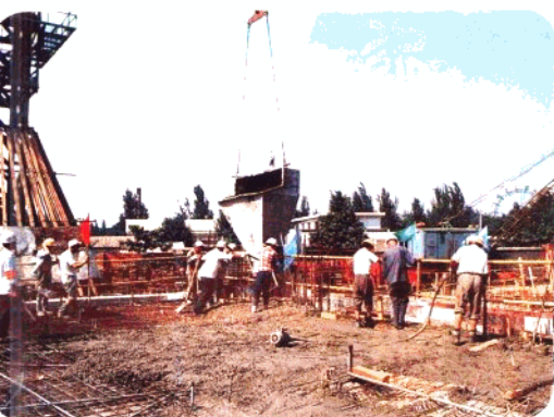
17 正在施工的工程
