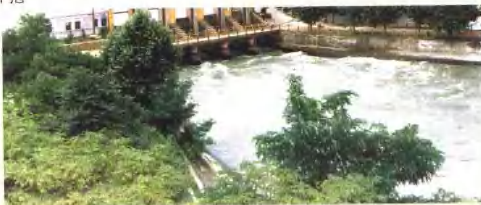
横排头渠首枢纽工程
