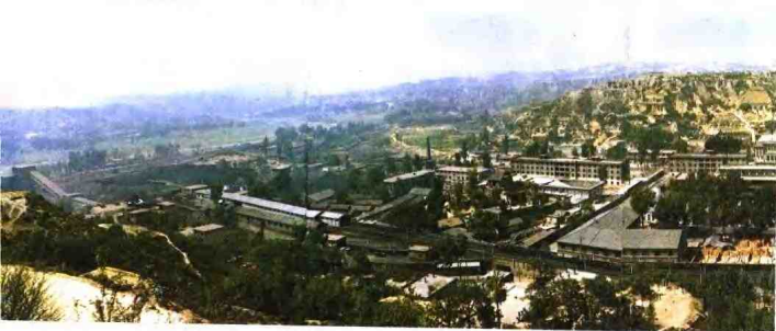
壮观的霍县矿务局辛置矿全景
